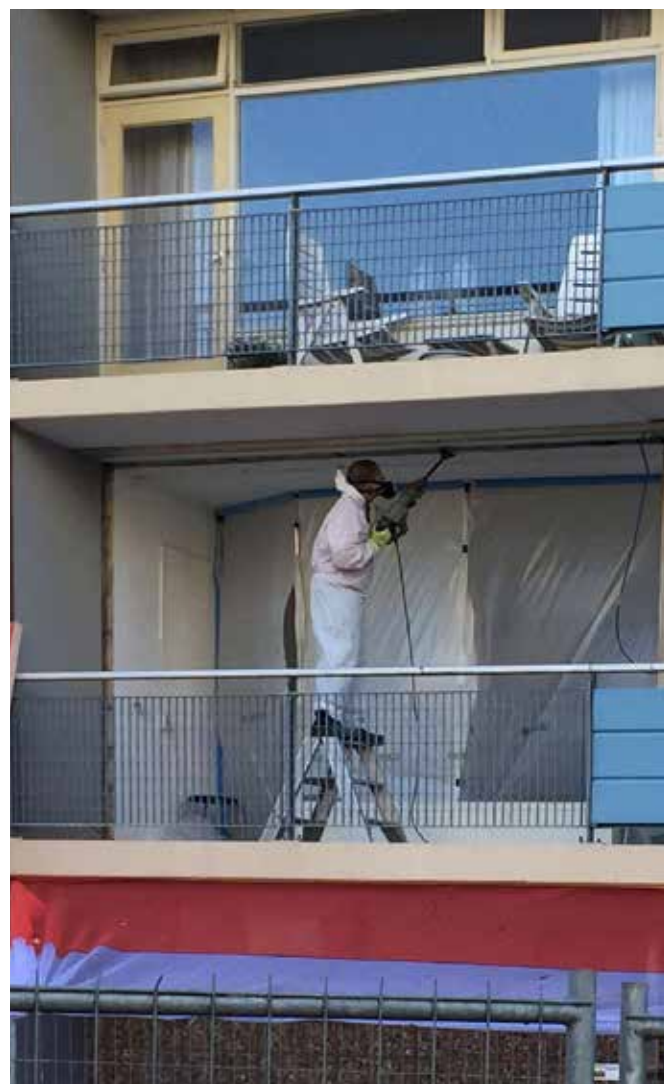
In de oude gevels zit asbest, dat zorgvuldig gesaneerd wordt. Pas nadat de gevels weer zijn vrijgegeven komt het treintje voor het groot onderhoud in werking.
