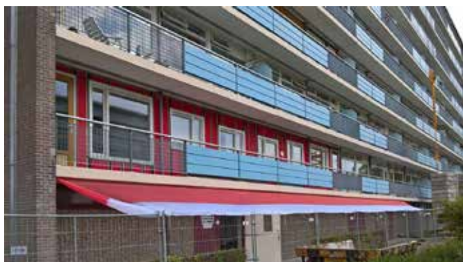
De glazen gevels aan de achterzijde worden vervangen door houtskeletbouwelementen met kunststof kozijnen.
