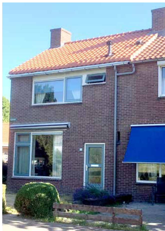
Gerenoveerde woning met o.a. een nieuw dak, isolatie en opgeknapte gevel.
