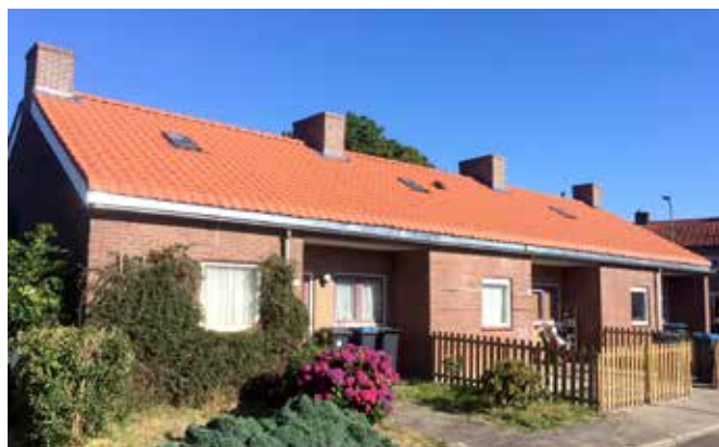
Een van de woningtypen die gerenoveerd is volgens het Trento renovatieconcept van Nijhuis.
